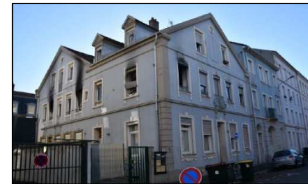
Vue générale de l'immeuble
