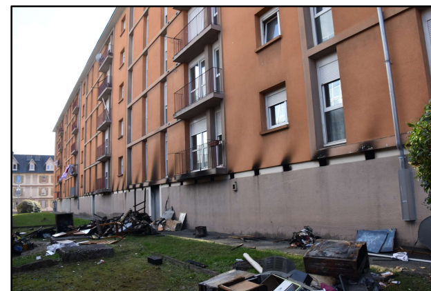
Départ de feu dans les caves. 60 résidents évacués.
