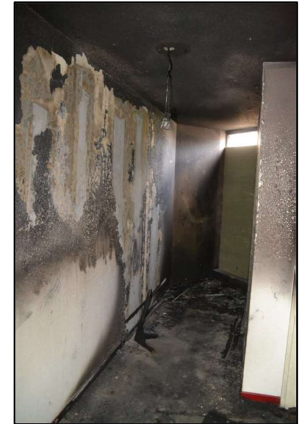
Epandage d'accélérant dans un couloir
